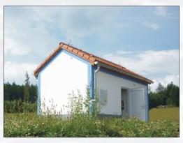
Společnost K&K TECHNOLOGY a.s. v roce 2019 vybudovala nový vodojem pro obec Hrádek u stávajícího vodojemu. Výstavba vodojemu v Hrádku nastala z důvodu nedostatečné kapacity a nevyhovujícího technického stavu. Nový vodojem má více než dvojnásobný objem 200 metrů krychlových a je zásoben vodou z prameniště a z přečerpávací nádrže. Zařízení je zásobárnou pitné vody pro cca 750 obyvatel. Obec je zásobena pitnou vodou gravitačně.
